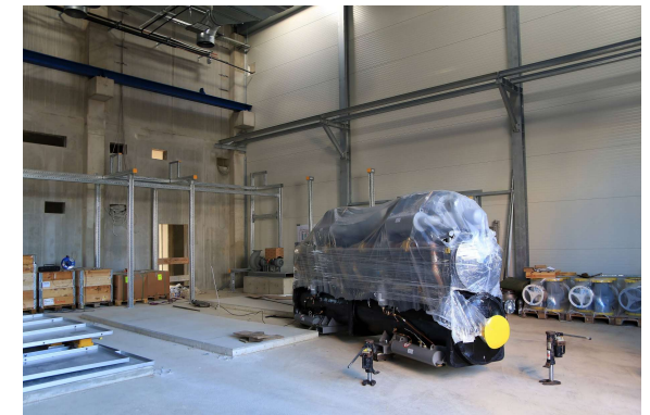
Geothermie in Schwerin: Wärmepumpen wurden geliefert
